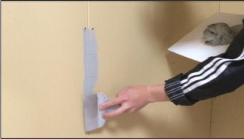
① ジョイント部分にパテを詰め込みます
