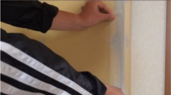
②ファイバーテープ貼り
