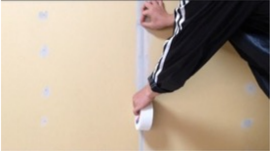
②ファイバーテープ貼り
