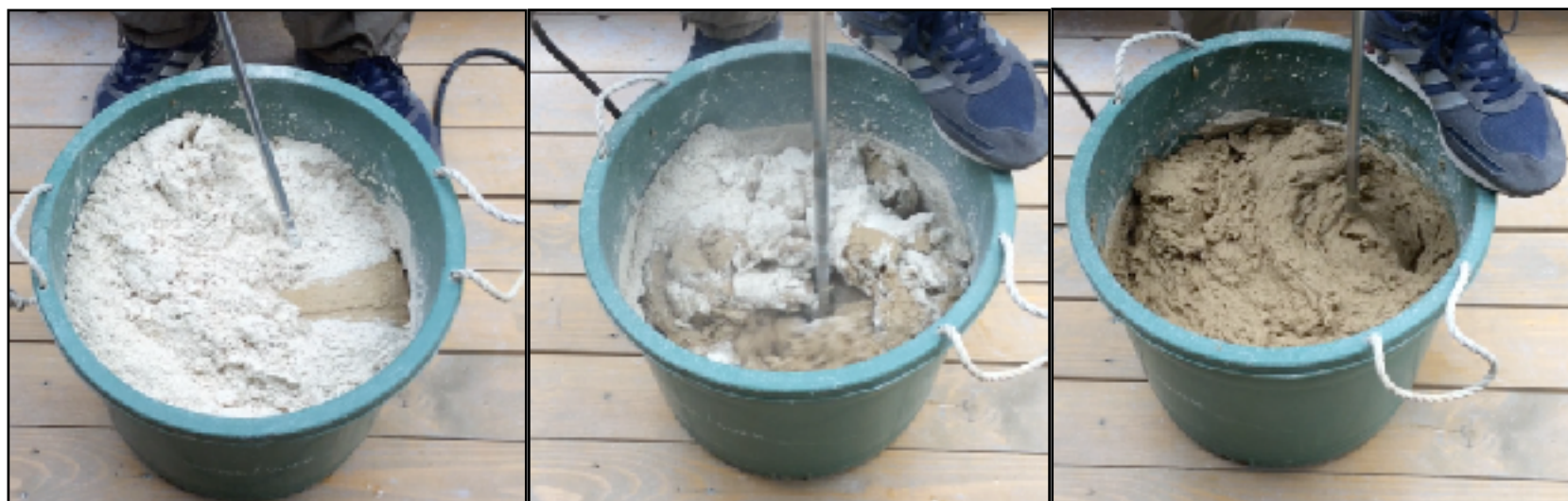
⑤ かくはん機を傾けて練った土と粉を少しずつ混ぜます。約5分かかります
