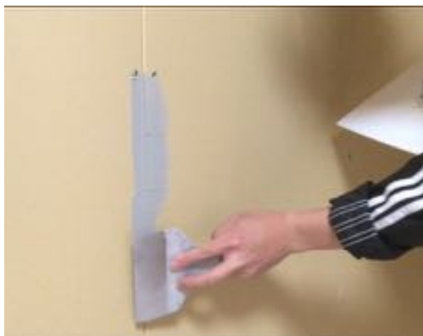
①下パテ打ち（石膏系パテ）
