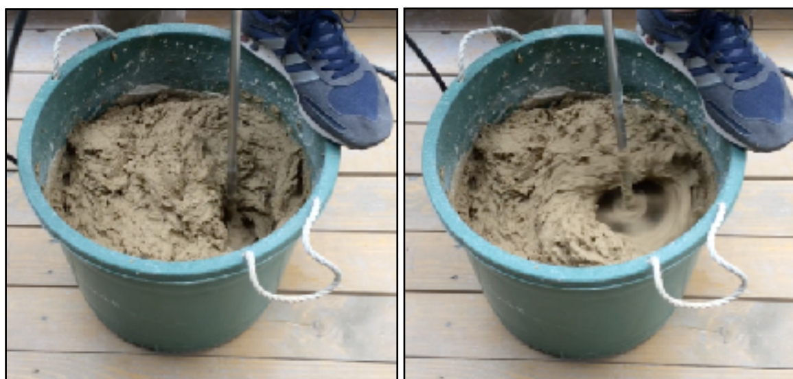
⑥ 粉が無くなったらかくはん機を上下に動かして全体を練ります
