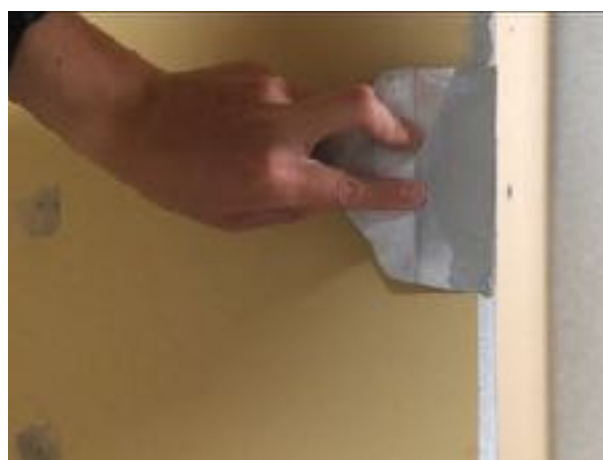
①下パテ打ち（石膏系パテ）
