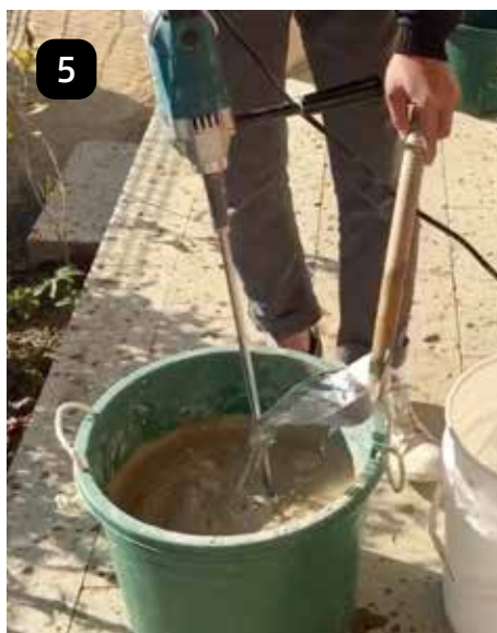
5 柄杓(400cc)2杯加水して、かくはん機で約1分練って完成
