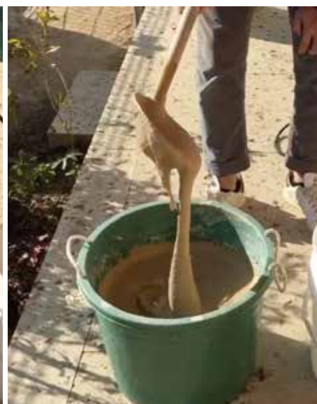
5 柄杓(400cc)2杯加水して、かくはん機で約1分練って完成
